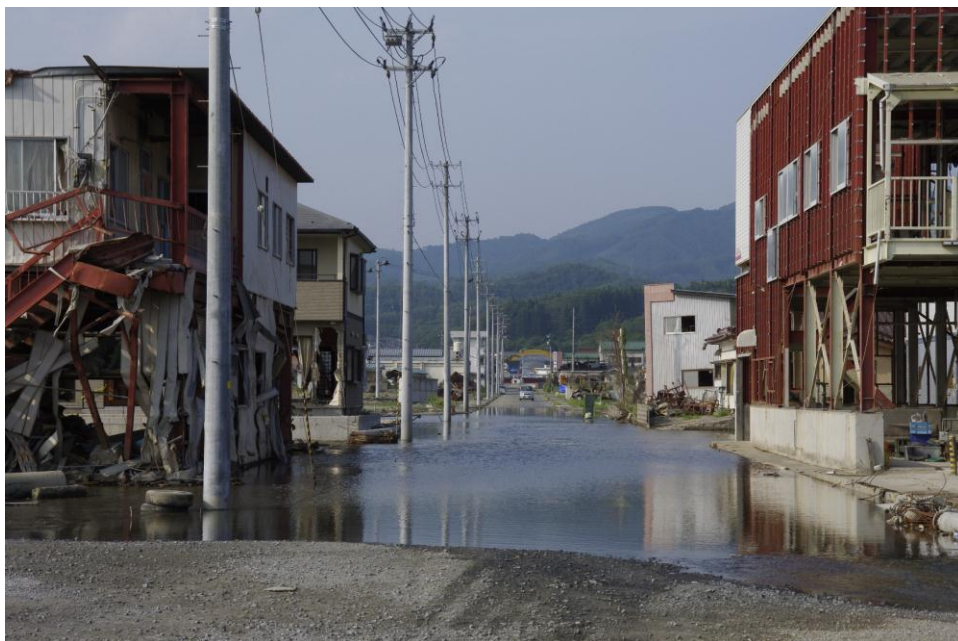
水没した道路(中みなと町)
